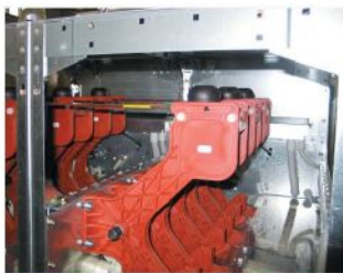
Рис.21. Изолированный отсек сборных шин
