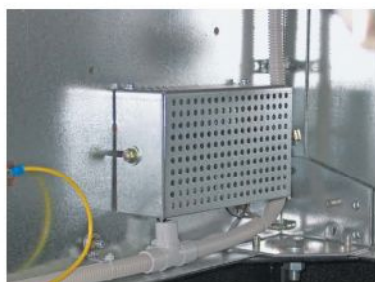
Рис.19. Антиконденсатные нагревательные элементы
