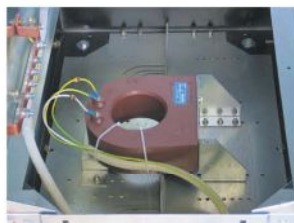
Рис.14. Трансформатор тока нулевой последовательности
