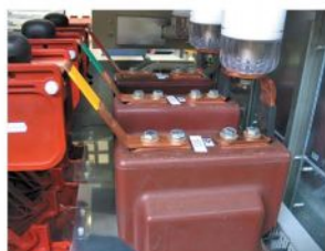
Рис.15. Трансформаторы тока
