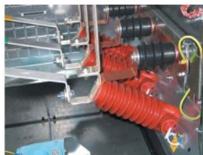
Рис.16. Емкостные делители напряжения
