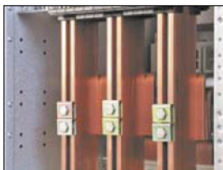
Рис. 18. Система из двух полос шин на фазу
