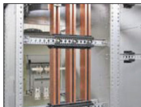
Рис. 19. Опоры-изоляторы
