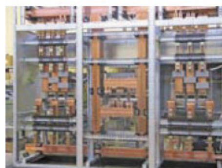
Рис. 21. Шинная система, номинальный ток 3200А
