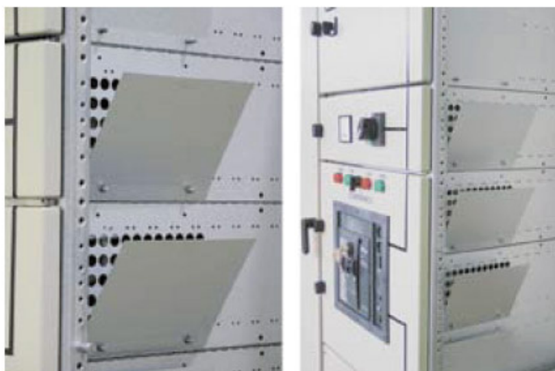
Рис.10. Клапаны сброса давления
