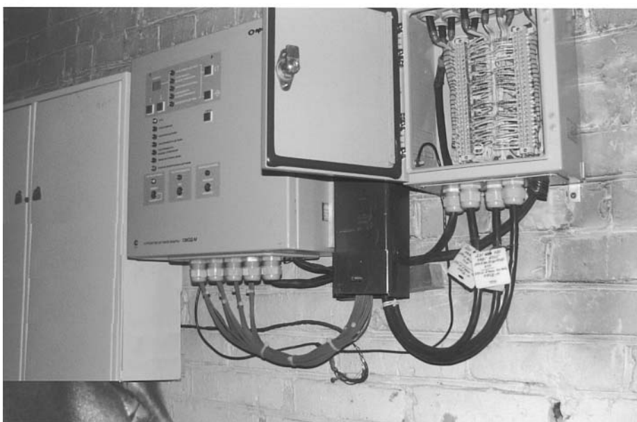
Рис. 11.4. Пример установки устройства на стене помещения КРУ.
