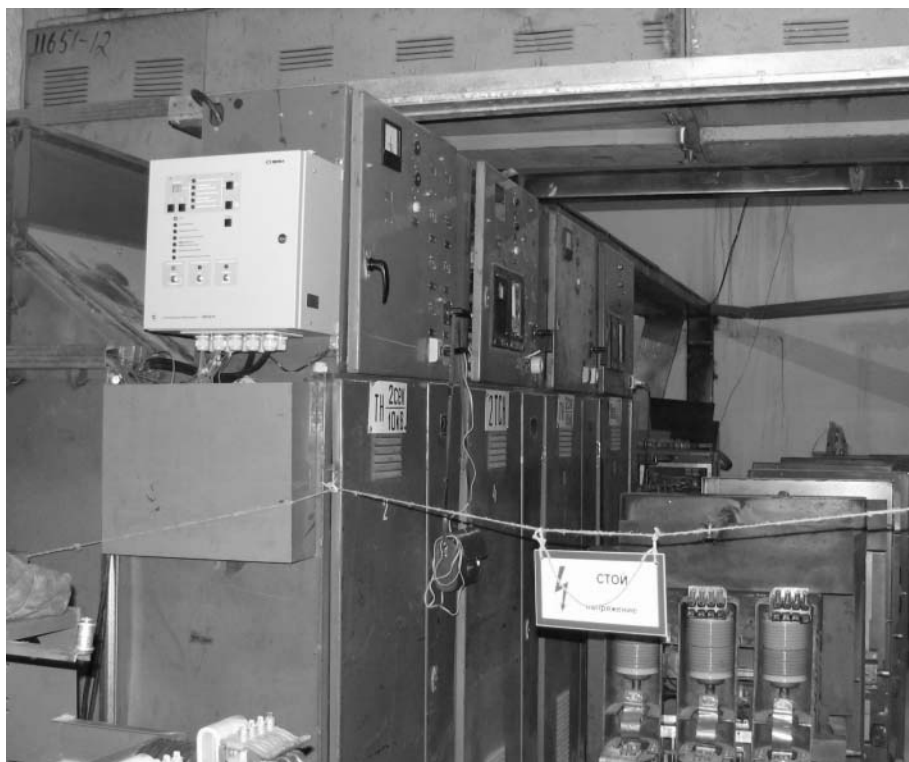
Рис. 11.3. Пример установки устройства на боковой стенке.
